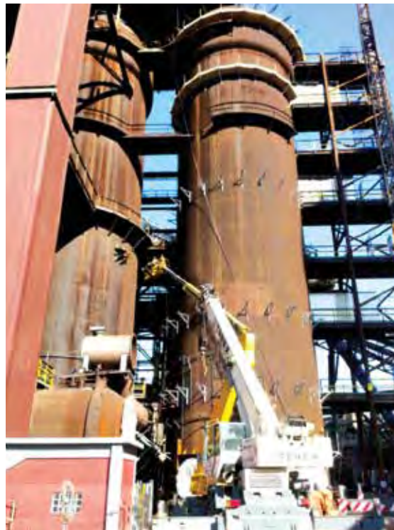
Cowper 14 - Altoforno 1 - Bonifica isolamento in amianto, demolizione Shell Metallico, Carpenterie Generali
