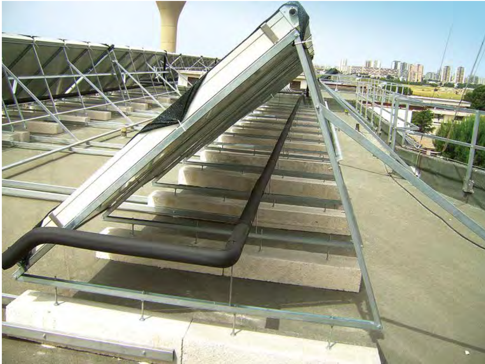
Realizzazione di un impianto solare termico
