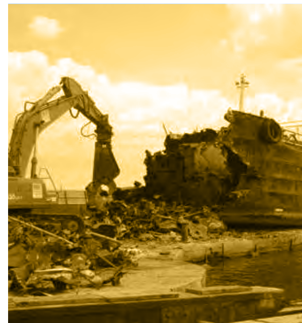
BONIFICHE AMBIENTALI E MESSA IN SICUREZZA
