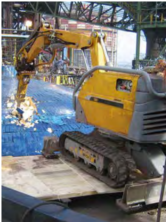
Lavori di demolizione e bonifica di due torri all'interno dello stabilimento ILVA di Taranto.
