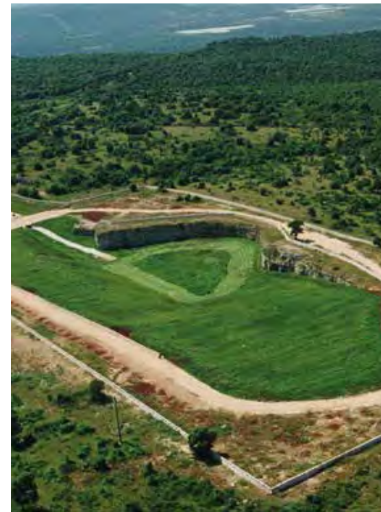
Lavori di bonifica ex discarica R.S.U. in località Bufalaria nel Comune di Martina Franca (TA).
