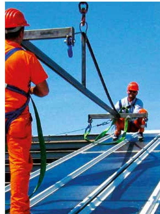
Realizzazione di un tetto ventilato fotovoltaico in grado di produrre energia elettrica e isolare termicamente l'edificio.
