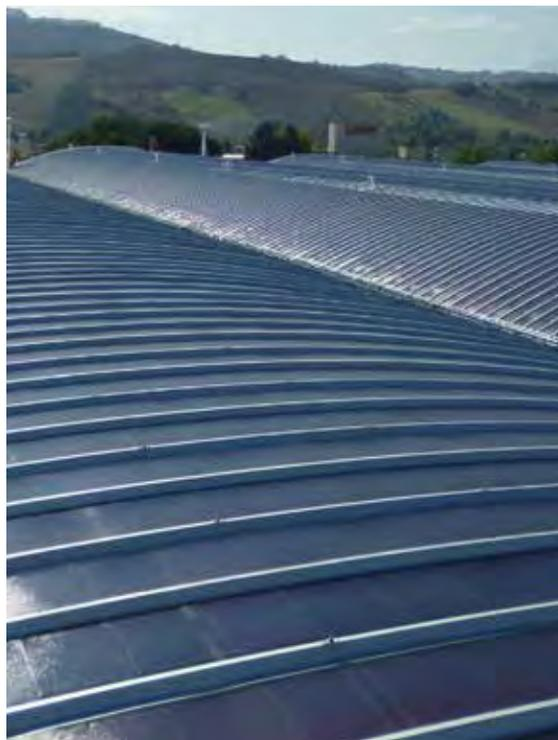
Realizzazione di un impianto fotovoltaico in silicio amorfo previa rimozione della copertura esistente in cemento amianto.
