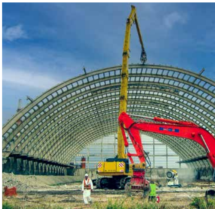
Crotone, Syndial SpA, Intervento di demolizione fabbricati
