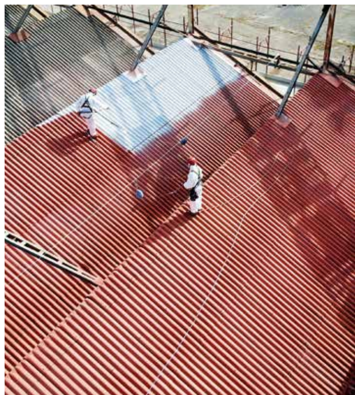
Bari, Caserma Rossani, bonifica mediante incapsulamento conservativo delle coperture in cemento amianto
