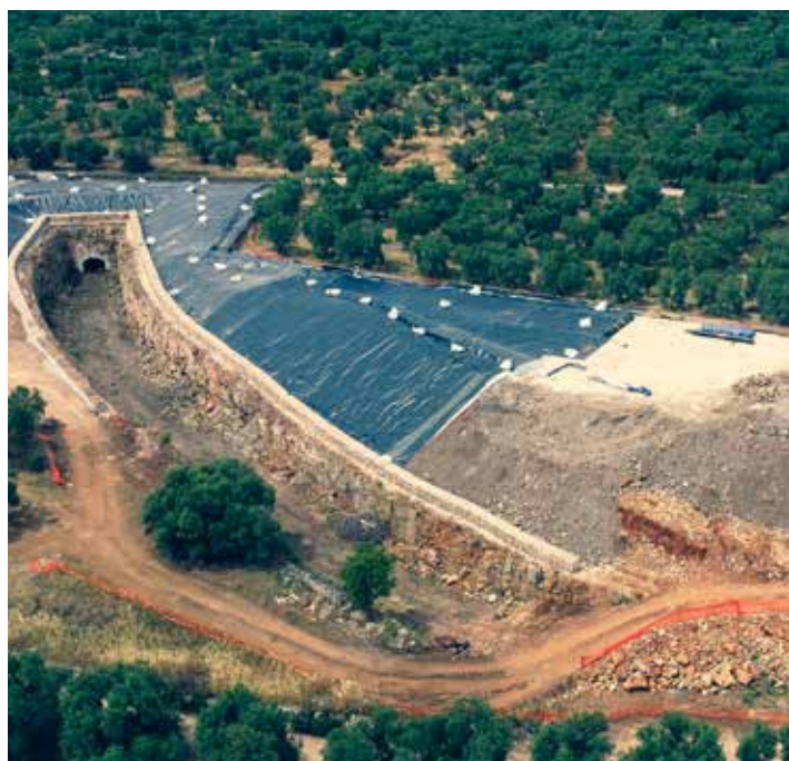
Sannicandro (BA), Bonifica e messa in sicurezza permanente ex discarica comunale
