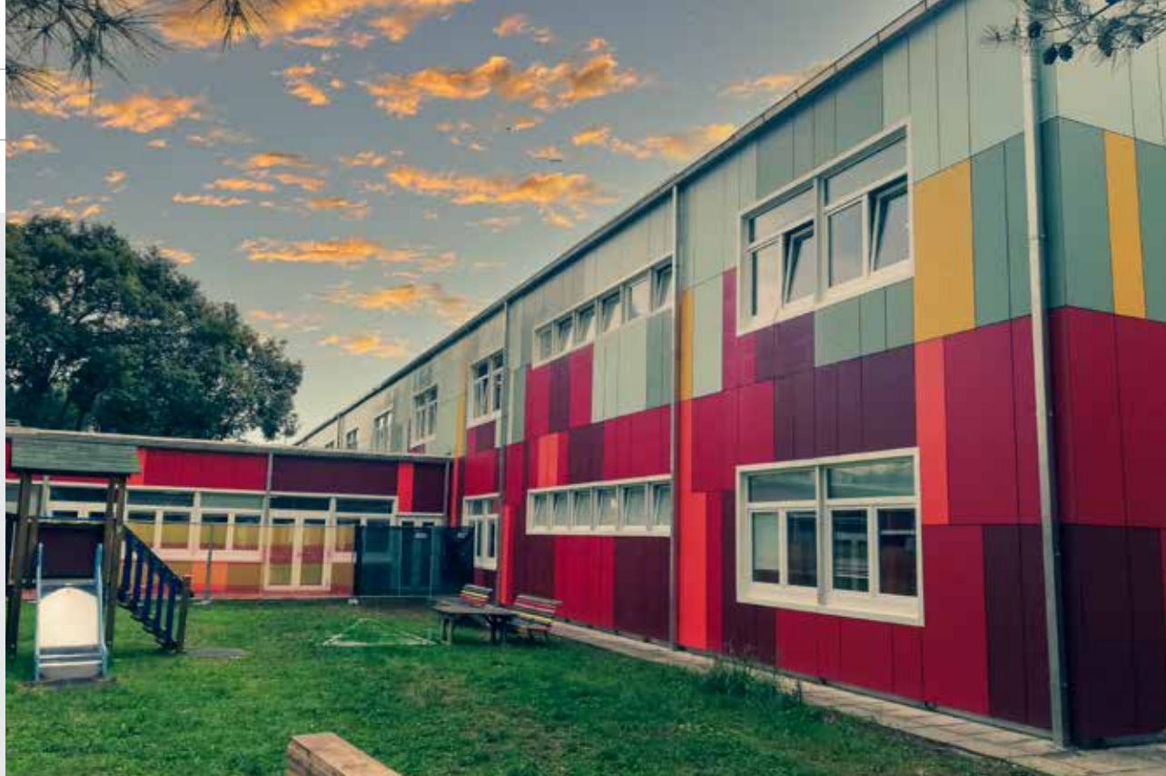
Foto Serveco: intervento di efficientamento energetico a Sestri Levante (GE)
