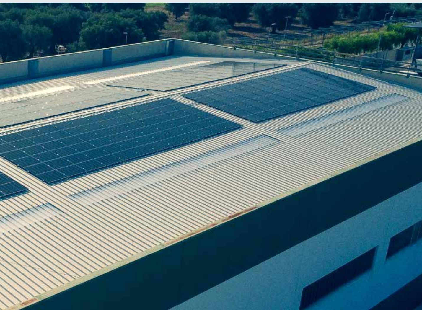
Foto Serveco: sede amministrativa a Montemesola
